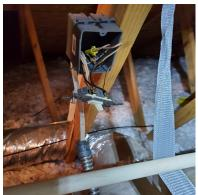
22. REFRIGERANT LINE IN ATTIC NEEDS INSULATION. NEEDS TO BE REPAIRED.
